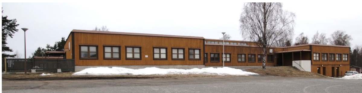
Kuva 14. Entinen koulurakennus itäpuolelta. / f.d. skolbyggnaden österifrån.
